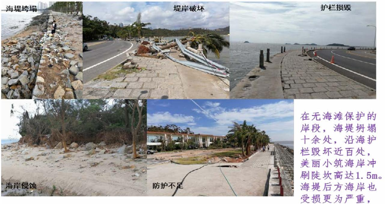
图 20 无海滩保护的岸段，台风过后堤岸垮塌、护栏损毁
